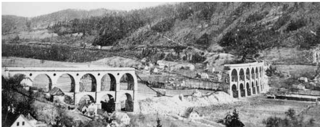
Na umiku je jugoslovanska vojska porušila viadukt Borovnica na progi Ljubljana-Trst
